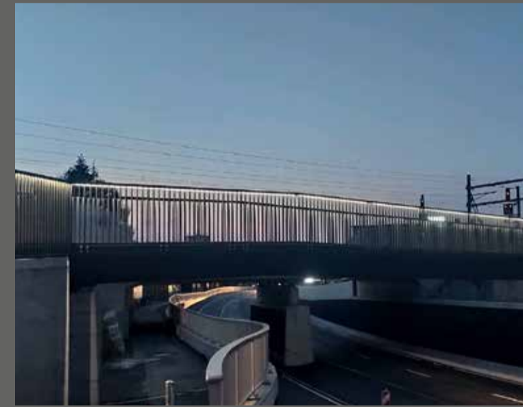
INLINE, éclairage du pont, Baar
