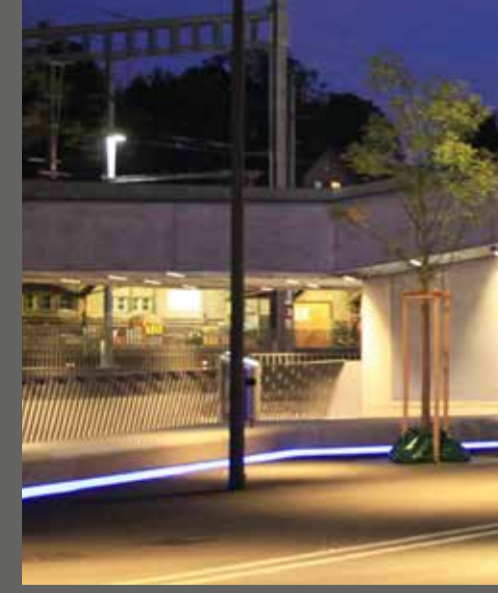
Poteaux d'éclairage avec spots, Winterthur
