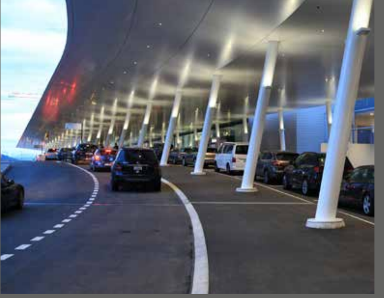
Spots de plafond BEAM, espace d'arrivée, aéroport de Zurich
