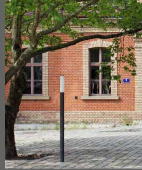
PUBLIC LIGHT, poteau d'éclairage, Vienne
