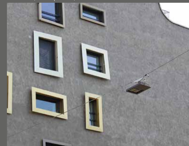
Luminaire sur câble METRO, Zurich
