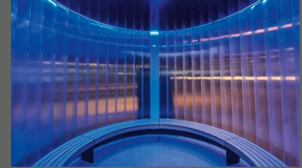
RGB Beleuchtung, Wartehalle GIBG, Glattzentrum/Richti-Areal, Wallisellen
