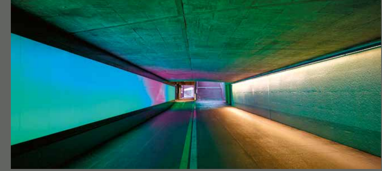
RGB Lichtwand mit Glas, Gleisquerung, Winterthur
