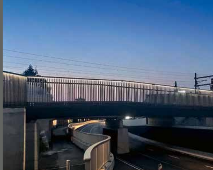
INLINE, Brückenbeleuchtung, Baar
