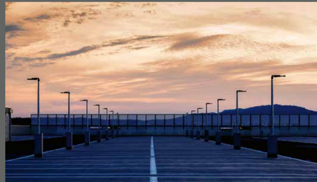
METRO mit Kandelaber, Parkdeck Flughafen Zürich
