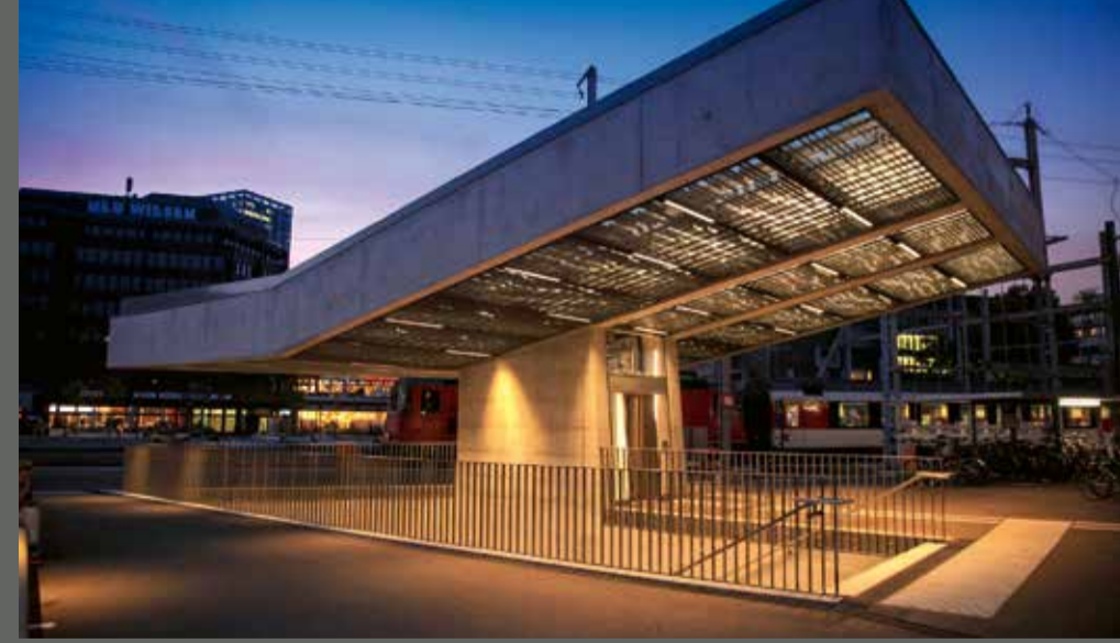
BEAM und INLINE, Gleisquerung, Winterthur
