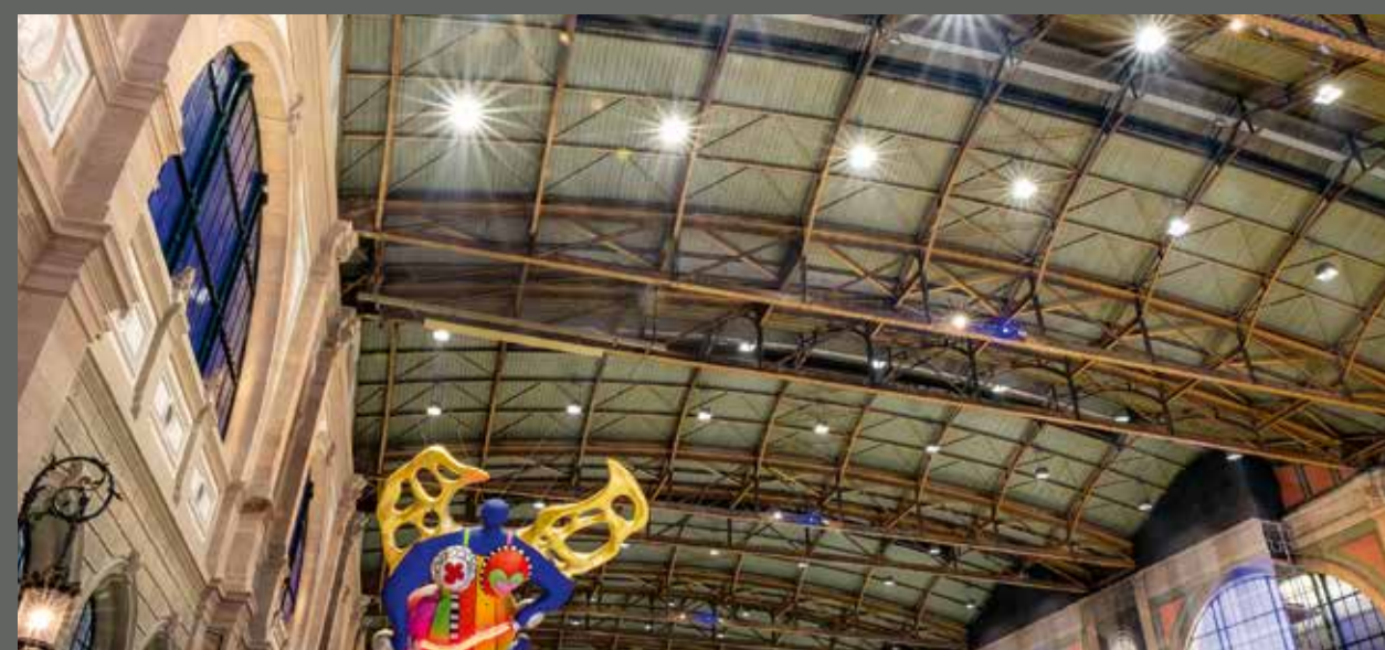
Spezialleuchten HUB, Zürich HB
