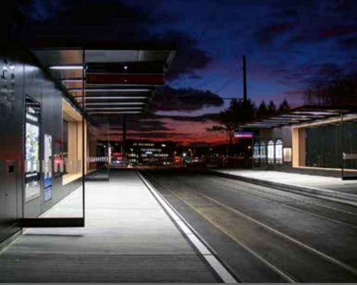
RECTANGULAR, Wartehallen Glattalbahn
